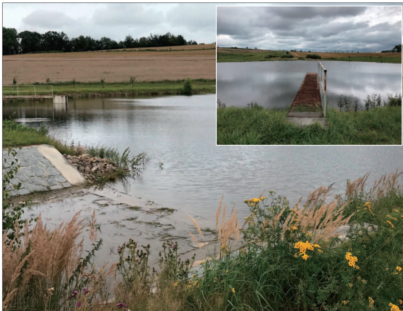
Hladina akumulované vody z drenážních systémů je až na úrovni bezpečnostního přelivu a zůstává v horní části dílčího povodí. Menší fotografie dokumentuje, jak malá je sběrná plocha systematické drenáže blízko rozvodnice, a přesto je nádrž plná.
