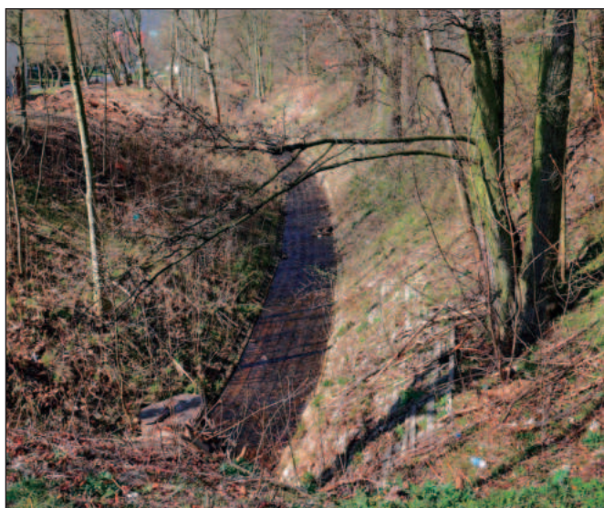
Obr. 12: Podúsek 6 koncipovaný na průtok větší než Q_{100} (vlastní foto)
