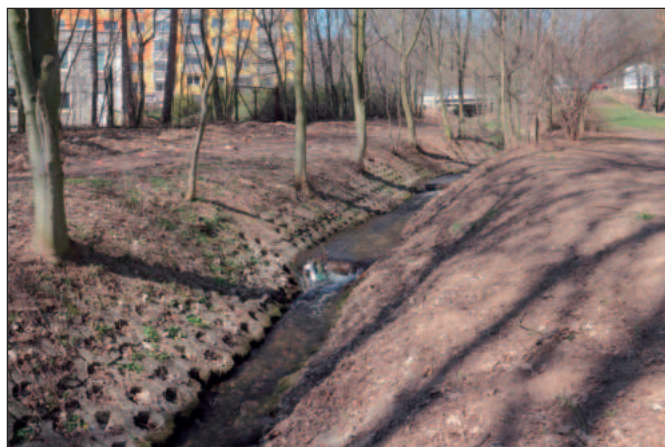
Obr. 2: Opevněné koryto mezi body 1 a 2 (vlastní foto)
