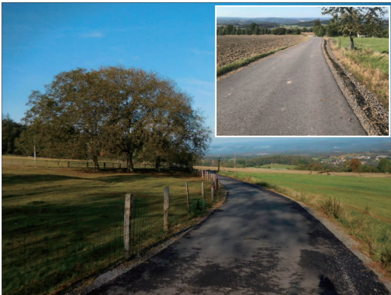
Realizovaná polní cesta jako společné zařízení komplexní pozemkové úpravy v Zadním Chlumu
