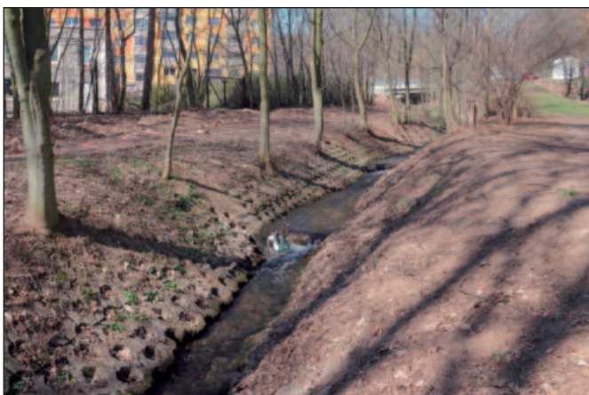
Obr. 2: Opevněné koryto mezi body 1 a 2 (vlastní foto)
