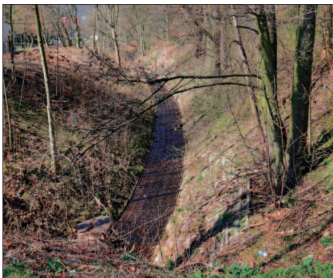
Obr. 12: Podúsek 6 koncipovaný na průtok větší než Q_{100} (vlastní foto)
